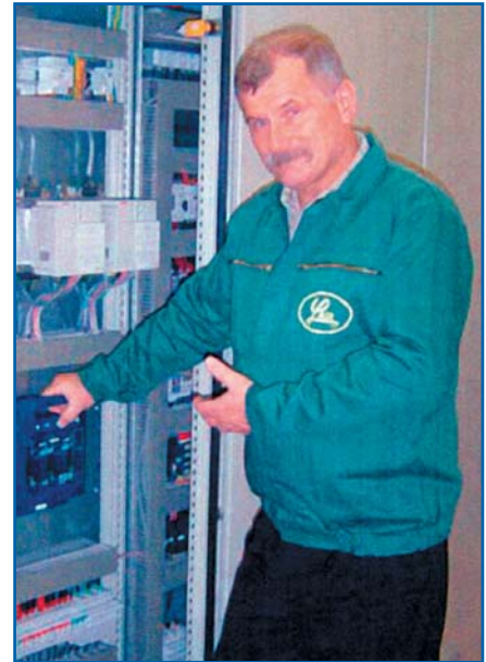
Jozef Kapuš, vedoucí výroby rozváděčů firmy LASR
