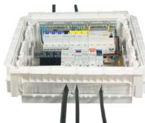
Plastové průchodky s lamelami se snadno přizpůsobí průřezu vodičů
